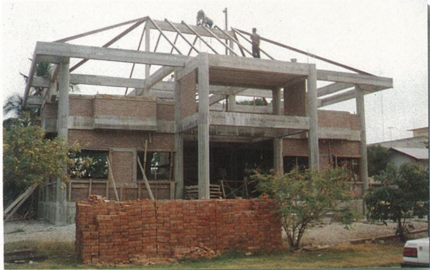
ขณะกำลังอยู่ในช่วงการก่อสร้าง อาคารคอนกรีต 2 ชั้น ขนาดพื้นที่ 415 ตารางเมตร
