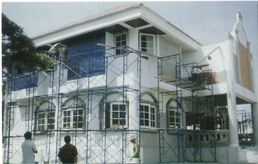
อาคารห้องสมุดที่เกือบเสร็จ
