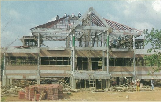
๑๒๐ วัน สำหรับการก่อสร้างตัวอาคาร
