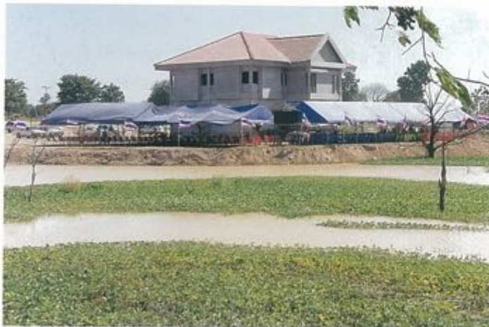
อาคารห้องสมุด เพิ่งก่อเป็นรูปทรง ยังไม่ได้ฉาบปูนทาสี
