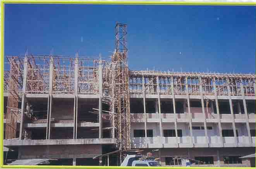
โครงสร้างอาคารชั้นที่ ๒-๓-๔
