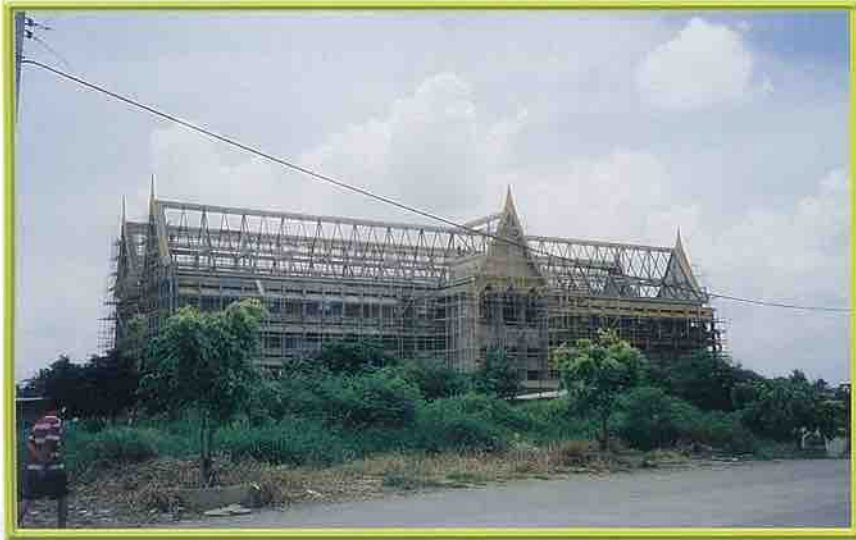
โครงสร้างหลังคาทรงไทย ๒ หลังคู่ ๕ มุข
