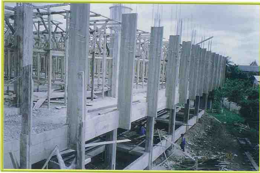
โครงสร้างอาคารชั้นที่ ๑
