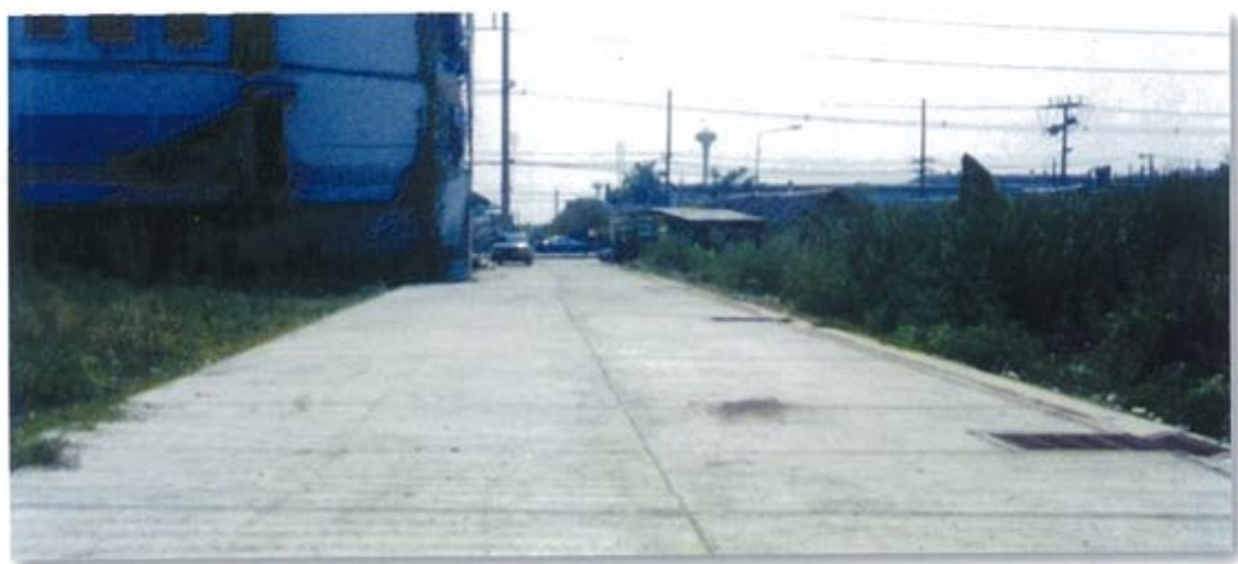
ฝังท่อระบายน้ำทำถนนเสร็จเรียบร้อยแล้ว
