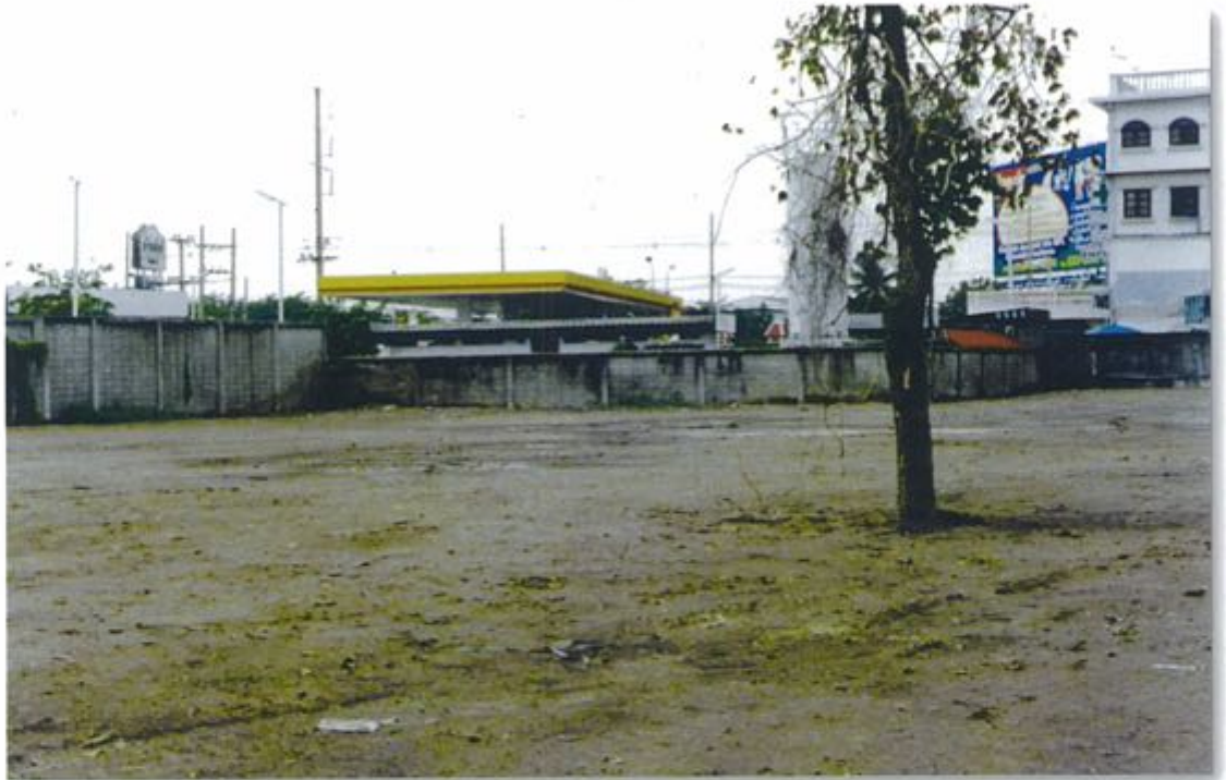
ถมดินปรับพื้นที่เสร็จเรียบร้อยแล้ว
