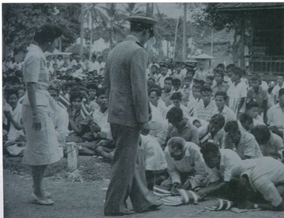
เสด็จพระราชดำเนินทรงเยี่ยมพสกนิกร บริเวณศาลากลางจังหวัดพัทลุง
