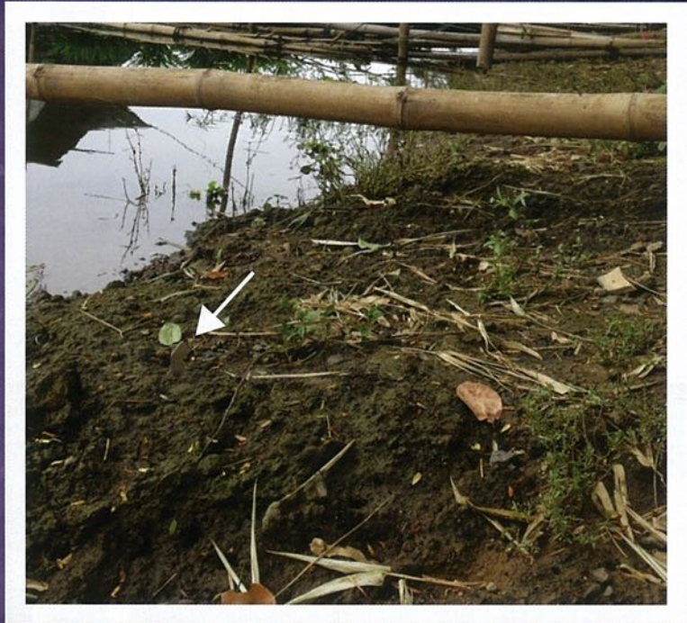
ดานเหล็กบางส่วนทรุดตัวอยู่ที่แม่น้ำสะแกกรัง เช่นบริเวณทำนน้ำบ้านนายบุญเสริม แม่นเมือง สันนิษฐานว่าเดิมเป็นดานที่อยู่บนบก ต่อมาเกิดการดูดทรายในแม่น้ำ ตลิ่งทรุดตัวลง ทำให้ดานเหล็กจมลงไปอยู่ใต้น้ำ
