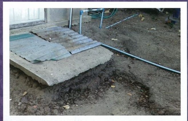
พบลานเหล็ก ที่เกิดจากตะกรันถลุงเหล็กทับถมดิน เป็นแผ่นหนาประมาณ ๑๕ - ๓๐ เซนติเมตร บริเวณบ้านนางถาวร(อวน) จันทร์เทเวศร์
