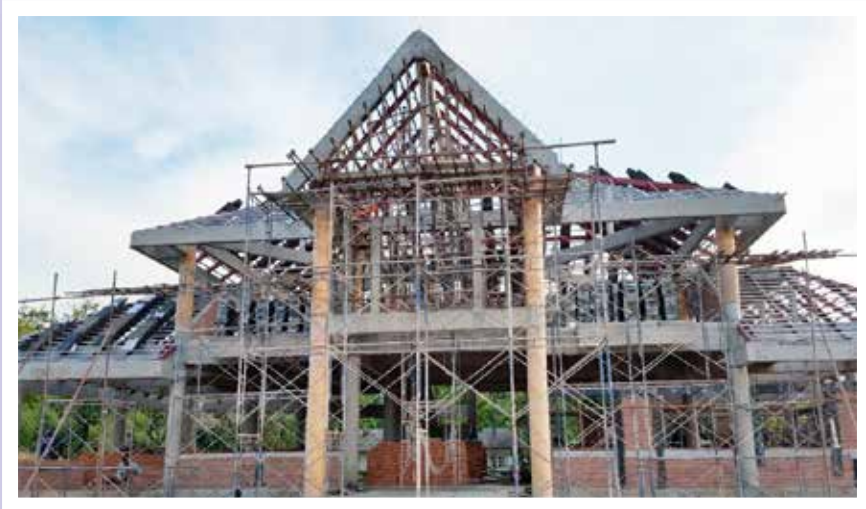
ภาพที่ ๖ การก่อสร้างห้องสมุดประชาชน “เฉลิมราชกุมารี” จังหวัดชัยภูมิ
