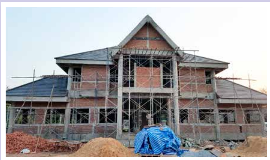
ภาพที่ ๗ การก่อสร้างห้องสมุดประชาชน “เฉลิมราชกุมารี” จังหวัดชัยภูมิ
