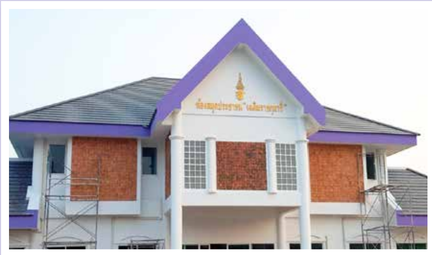
ภาพที่ ๑๐ การก่อสร้างห้องสมุดประชาชน “เฉลิมราชกุมารี” จังหวัดชัยภูมิ
