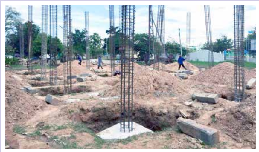
ภาพที่ ๕ การก่อสร้างห้องสมุดประชาชน “เฉลิมราชกุมารี” จังหวัดชัยภูมิ
