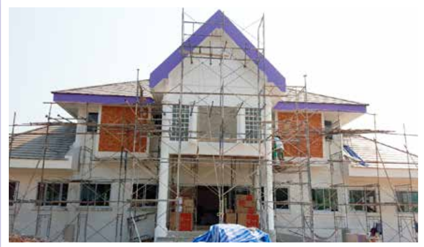
ภาพที่ ๘ การก่อสร้างห้องสมุดประชาชน “เฉลิมราชกุมารี” จังหวัดชัยภูมิ
