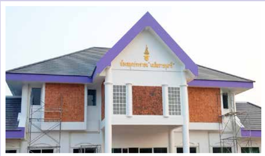
ภาพที่ ๙ การก่อสร้างห้องสมุดประชาชน “เฉลิมราชกุมารี” จังหวัดชัยภูมิ
