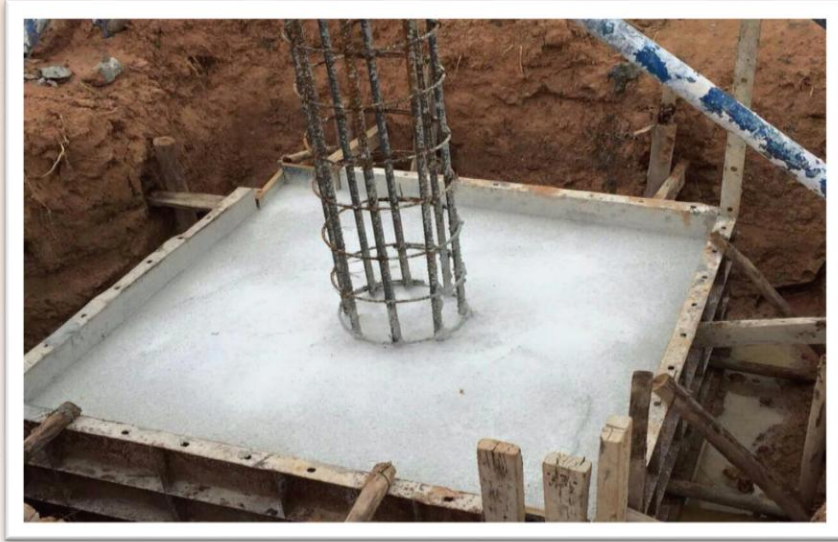
ภาพที่ ๔ ตอกเสาเข็มในการก่อสร้างห้องสมุดประชาชน “เฉลิมราชกุมารี” จังหวัดชัยภูมิ
