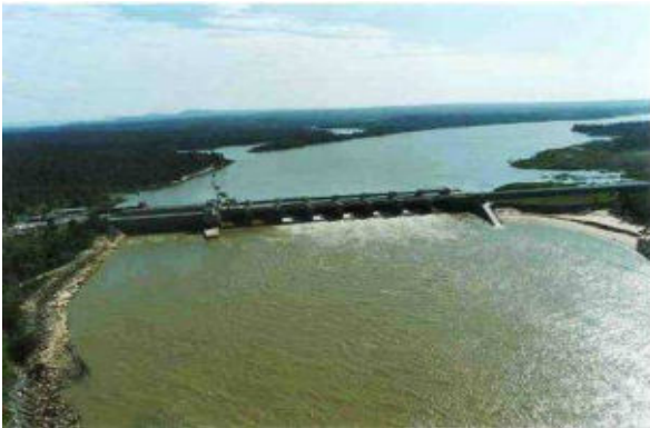
โรงไฟฟ้าพลังน้ำ เขื่อนปากมูล จังหวัดอุบลราชธานี กั้นแม่น้ำมูล มีกำลังการผลิต 136 เมกะวัตต์
