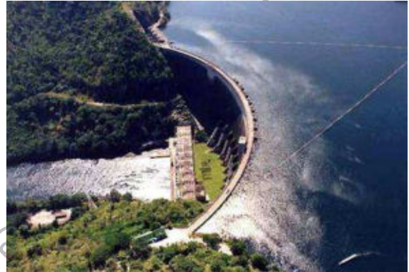
โรงไฟฟ้าพลังน้ำ เขื่อนภูมิพล จังหวัดตาก กั้นแม่น้ำปิง มีกำลังการผลิต 779.2 เมกะวัตต์
