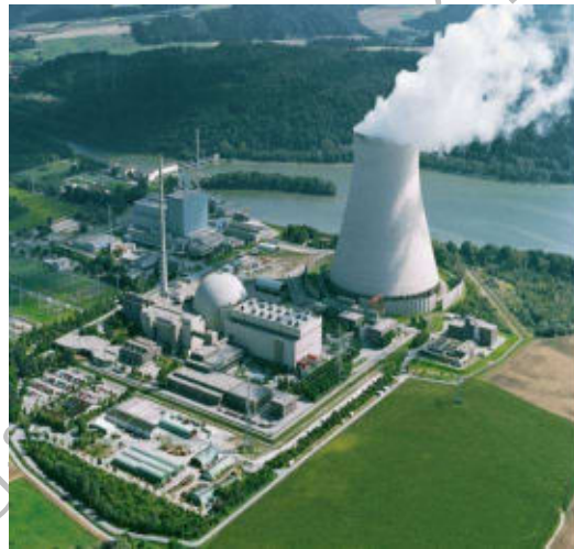
ภาพโรงไฟฟ้าพลังงานนิวเคลียร์และหอระบายความร้อน
