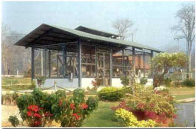
ภาพโรงไฟฟ้าพลังความร้อนใต้พิภพฝางของ กฟผ.
