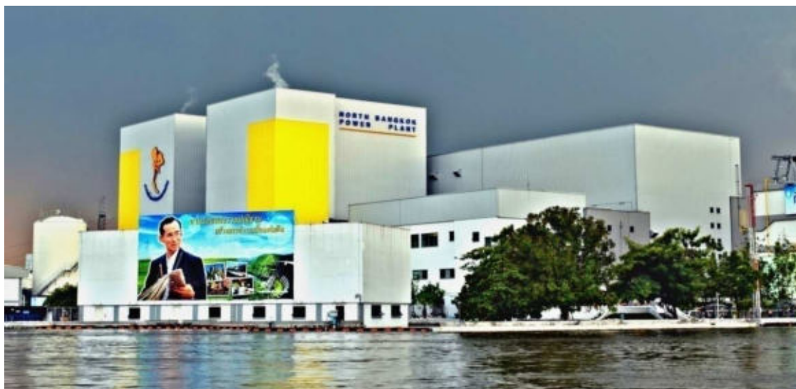
ภาพโรงไฟฟ้าพระนครเหนือ อำเภอบางกรวย จังหวัดนนทบุรี ใช้ก๊าซธรรมชาติเป็นเชื้อเพลิง
